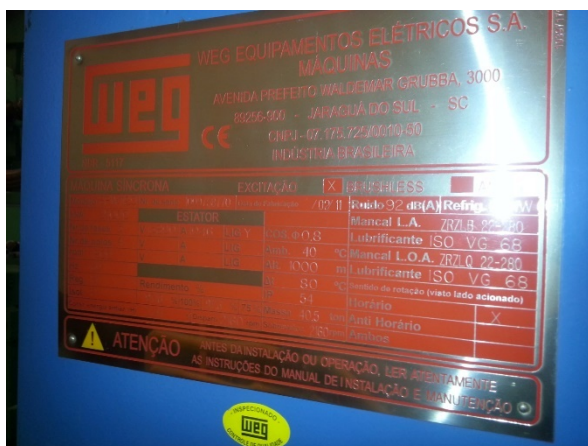
Nameplate data: Alternator/ Generator nº 3 (UTE Coruripe Iturama)
