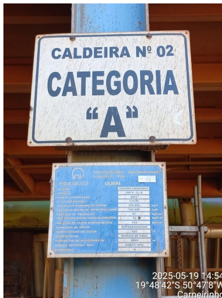
Nameplate data: Boiler nº 2
