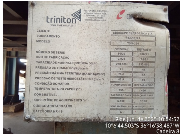
Nameplate data: Boiler nº 8 Coruripe Energética (CVW)
