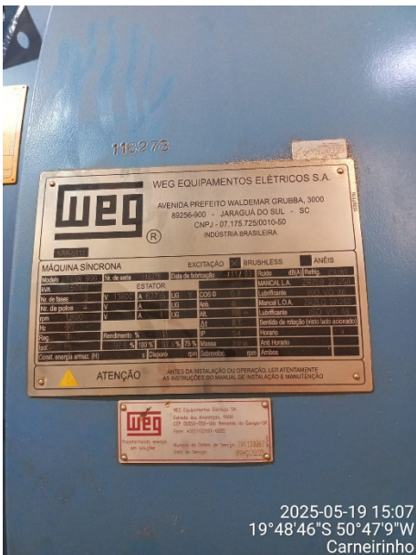
Nameplate data: Alternator/ Generator nº 1
