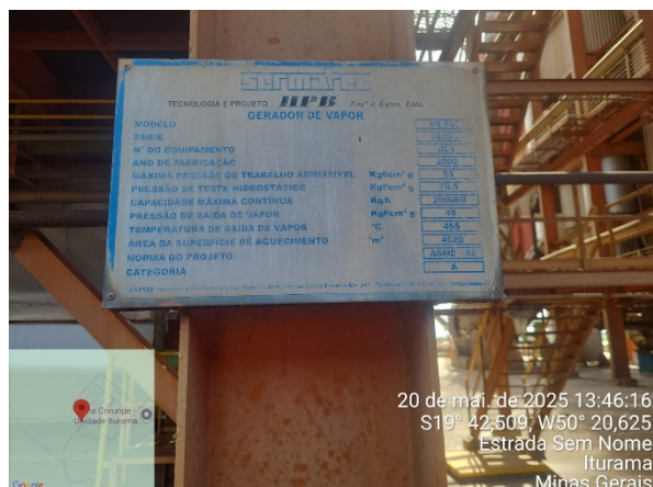
Nameplate data: Boiler nº 3 Energética Iturama
