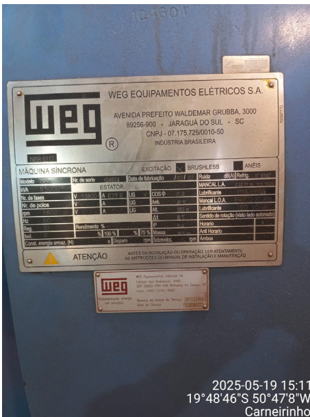
Nameplate data: Alternator/ Generator nº 2
