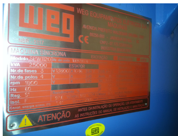
Nameplate data: Alternator/ Generator nº 3 (UTE Coruripe Iturama)
