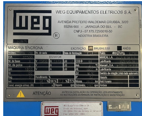
Nameplate data: Alternator/ Generator nº 1 (UTE Coruripe Energética Campo Florido)
