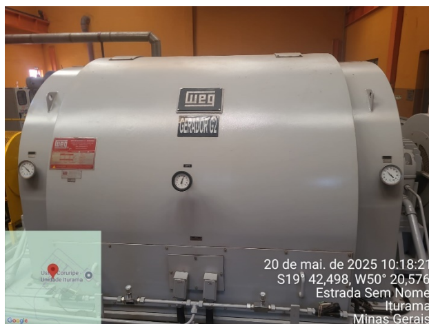
Alternator/ Generator nº 2 (UTE Coruripe Energética Iturama)
